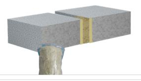
3. AC Putty mittels einer Presspistole einbringen (gegebenenfalls Fugen abkleben).
